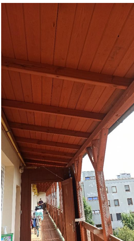
Rys. 3 Widok konstrukcji zadaszenia galerii
