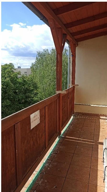
Rys. 2 Widok konstrukcji zadaszenia galerii
